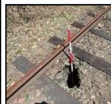
6k250m 軌道変状(陥没)
